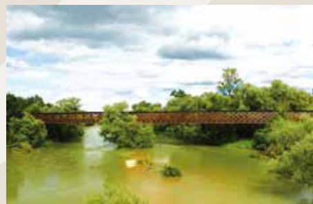
● Vue de l'ancien pont de chemin de fer sur le Doubs
