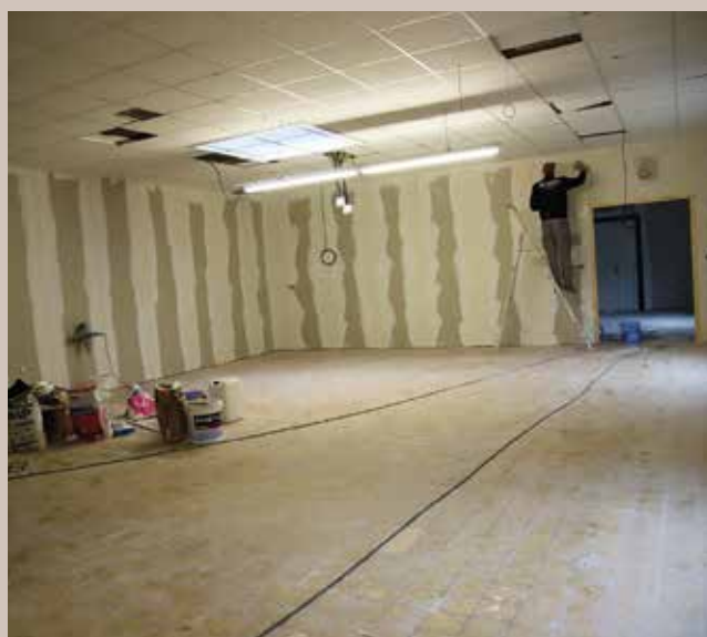
• Des travaux ont été réalisés à l'arrière de l'ancien Lidl avant l'emménagement de l'école des beaux-arts
