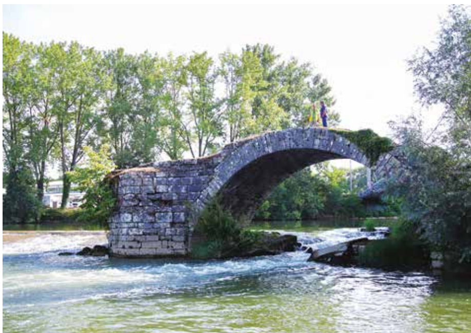
● L'arche du pont roman sera restaurée.
