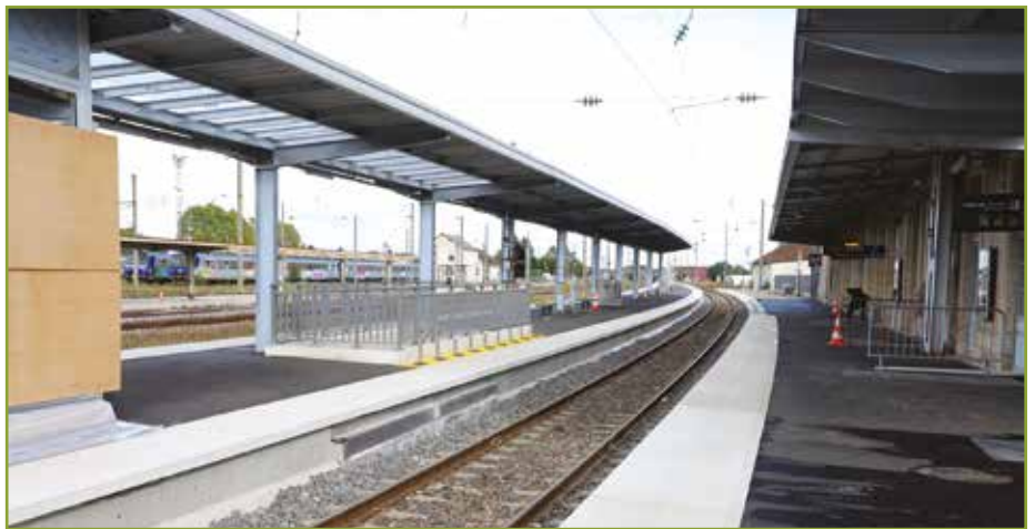
• Les quais réhaussés seront désormais accessibles par tous.
